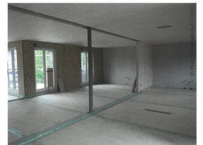
Abb. 4: Die massivholzernen BSP-Decken und -Innenwände haben in Teilbereichen einen deckengleichen Stahlträger als zusätzliche innere Tragachse erhalten
