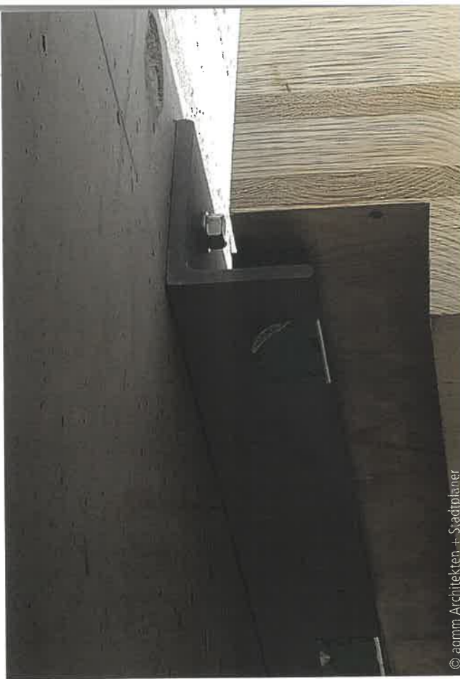
Abb. 2: Die Brettspertholzdecken wurden mit Stahlwinkeln am Stahlbeton-Erschließungskern befestigt
