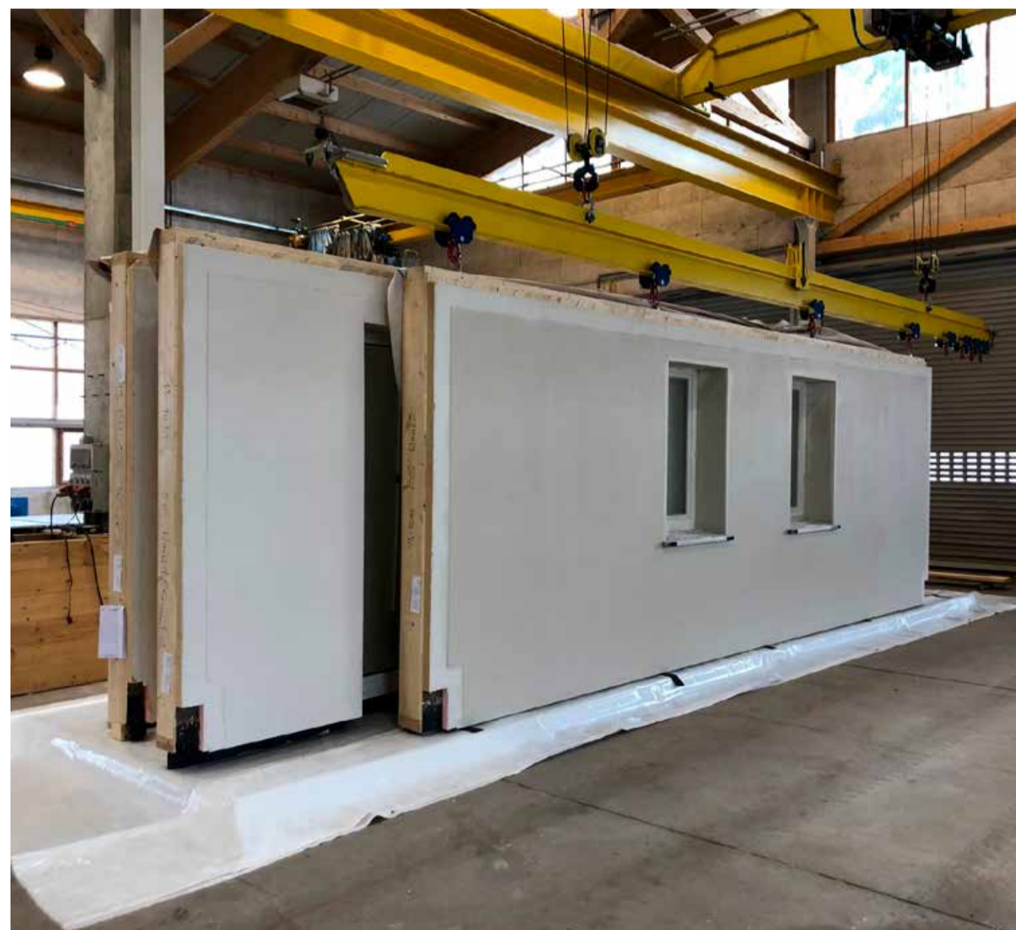
Carico degli elementi prefabbricati sul pianale intercambiabile
