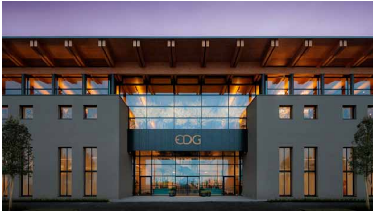
EDG Enzo De Gasperi. Costruzione del tetto Luogo S. Maria di Sala, VE
