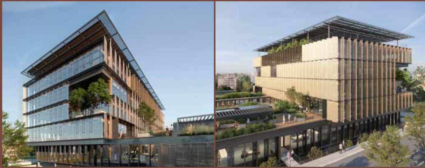
Luogo Lodi, LO Progettista Lombardini22 Impresa di costruzioni Edilteco Restauri Srl Posa struttura in legno 2024
