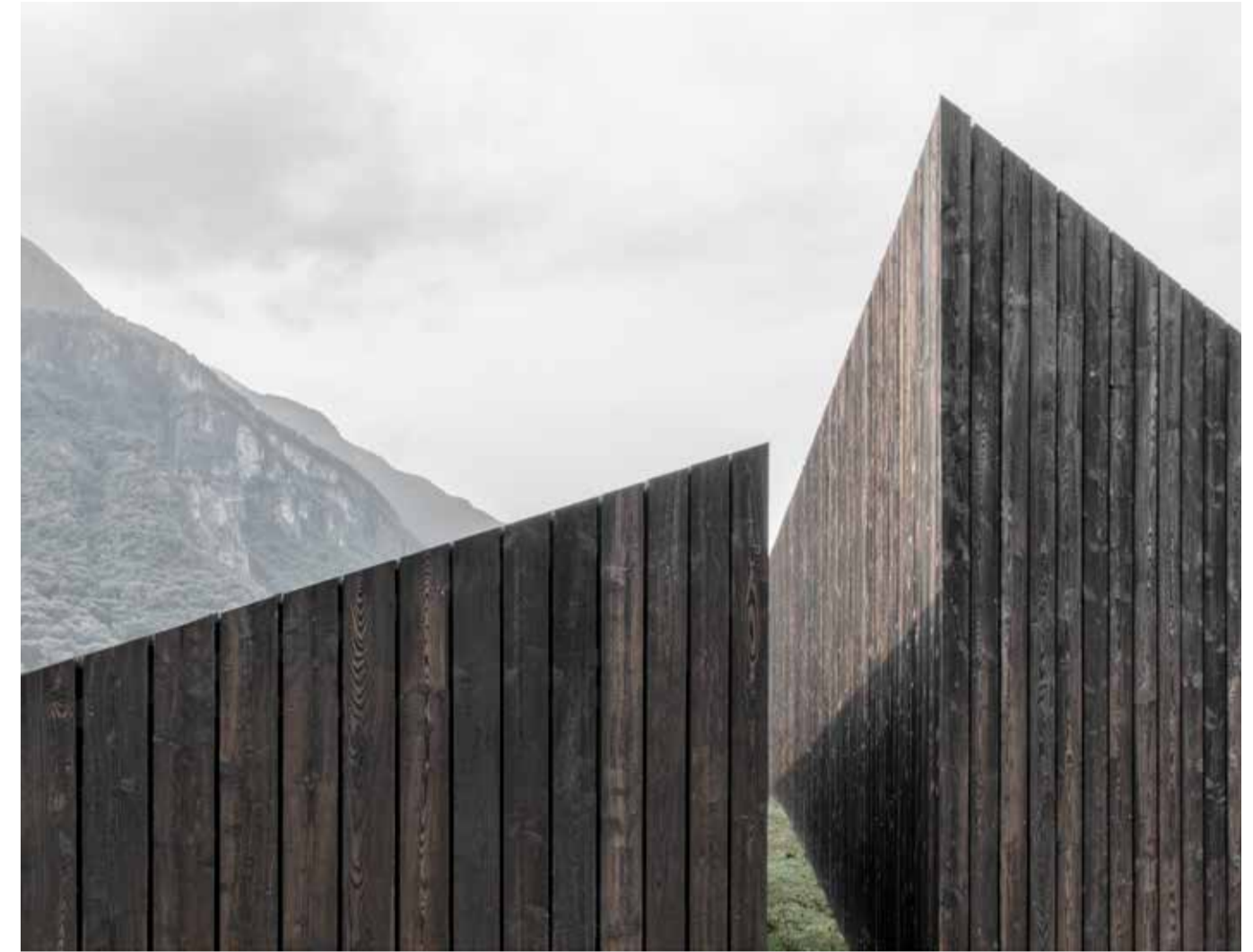
Il rivestimento esterno in pannelli di larice si estende anche al tetto. Le tavole sono state in parte fiammate e trattate con olio di lino, in parte spazzolate e smaltate con colore rosso-bruno.
