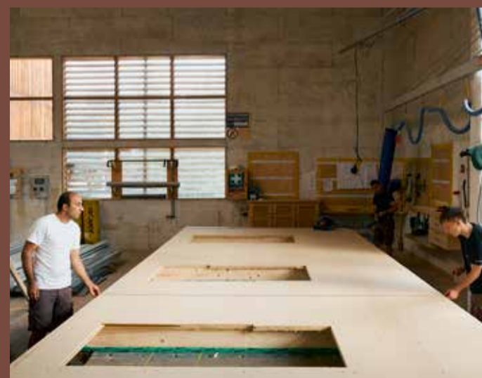
Prefabbricazione dell'involucro dell'edificio LignoTherm® a Nova Ponente.
