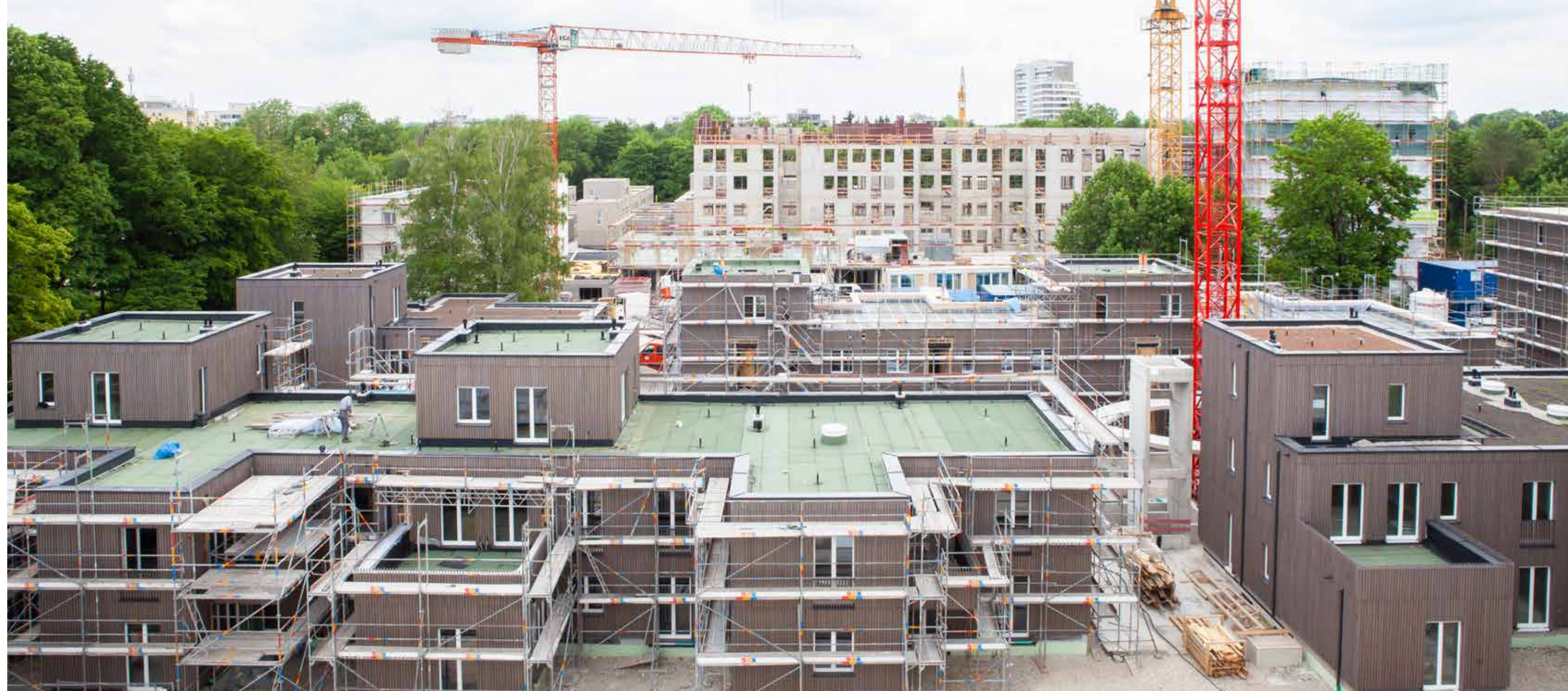
Il cantiere del villaggio ecologico a Monaco, in Prinz Eugen Park, è il più grande insediamento residenziale in legno della Germania con quasi 600 appartamenti. In primo piano: il complesso residenziale "gemeinsam größer II" realizzato da LignoAlp.
